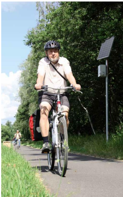
Radzählstelle mit Solarpaneel, Foto: Radschlag, 2011
