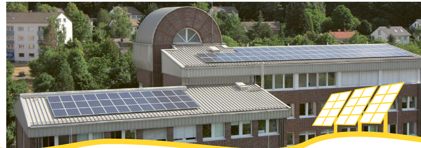
Auf dem Dach des Kreis-Job-Centers erzeugt eine neue Photovoltaik-Anlage bis zu 28.500 Kilowattstunden Ökostrom im Jahr. Quelle: © Landkreis Marburg-Biedenkopf
