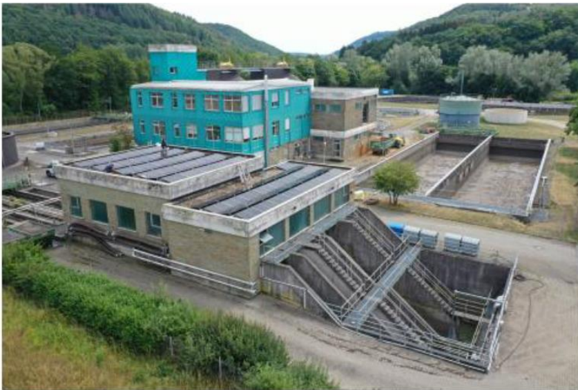
Dach-PV-Anlage Kläranlage Wallau, Quelle: Abwasserverband Perfgebiet, Bad Laasphe
