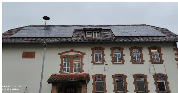
Photovoltaik-Anlage Grundschule Oberrosphe Quelle: Landkreis Marburg-Biedenkopf
