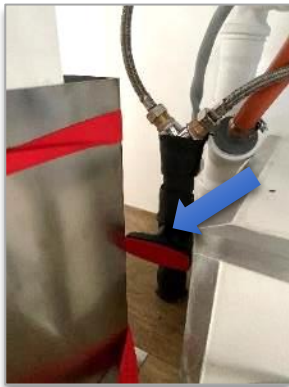
Bild 26: Öffnen des Wasser-Haupt- hahnes unter der Spüle
