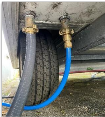
Bild 3: Trinkwasser- und Abwasseranschluss am Spülmobil
