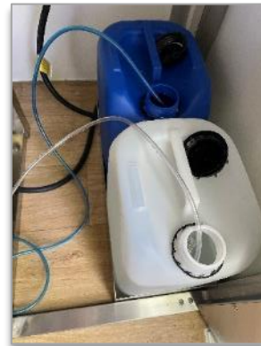
Bild 28: Spülmittelkanister öffnen und Zulaufschläuche für Spülmaschine in Öffnungen einführen
