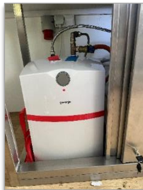
Bild 27: Den Durchlauferhitzer unter der Spüle auf Position „e“ stellen. Er versorgt nur das Spül- becken mit Warmwasser, nicht die Spülmaschine
