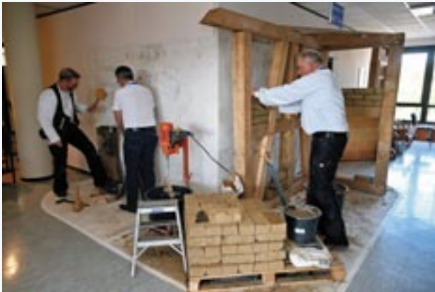
Der Fachbereich Bauen, Wasser und Naturschutz demonstrierte alte Handwerkstechniken rund ums Fachwerk mit Lehmörtel und Lehmsteinen.
