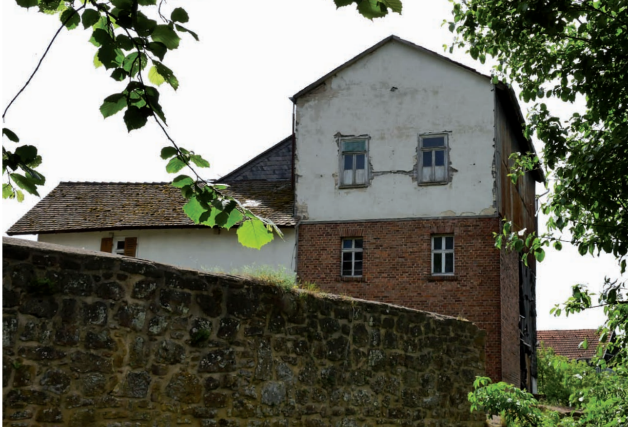
Die ehemalige Deutschordensmühle in Kirchhain könnte zu einem Mitmachmuseum zu Energie werden.
