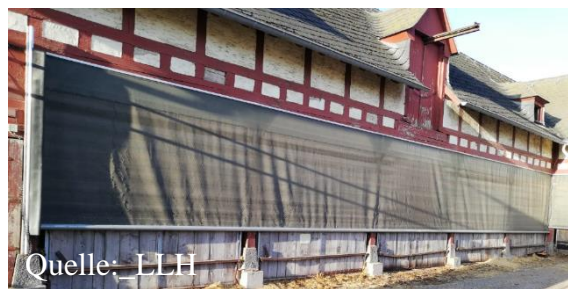
Abb. 3: Sicherung mit Windschutznetz
