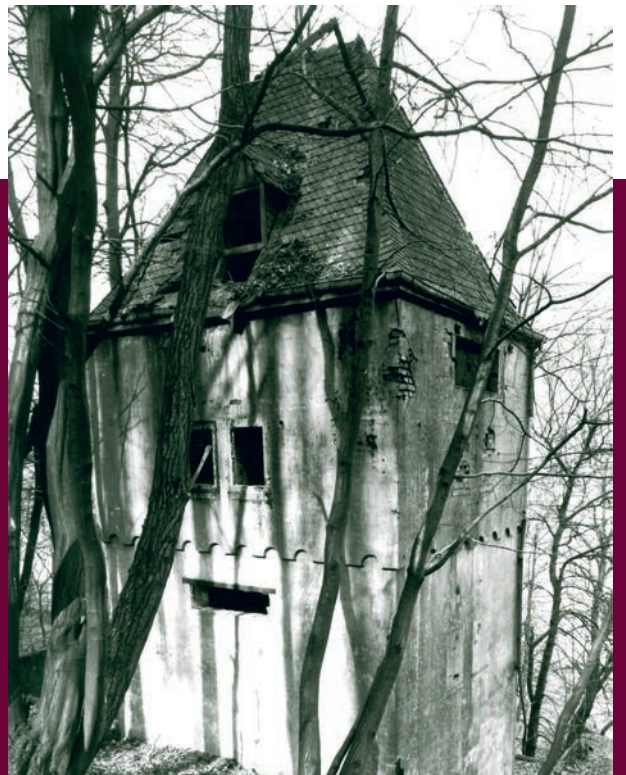
Transformatorhaus Ludwigshütte, Landkreis Marburg-Biedenkopf Fotosammlung E. Schneider, Landkreis Marburg-Biedenkopf
