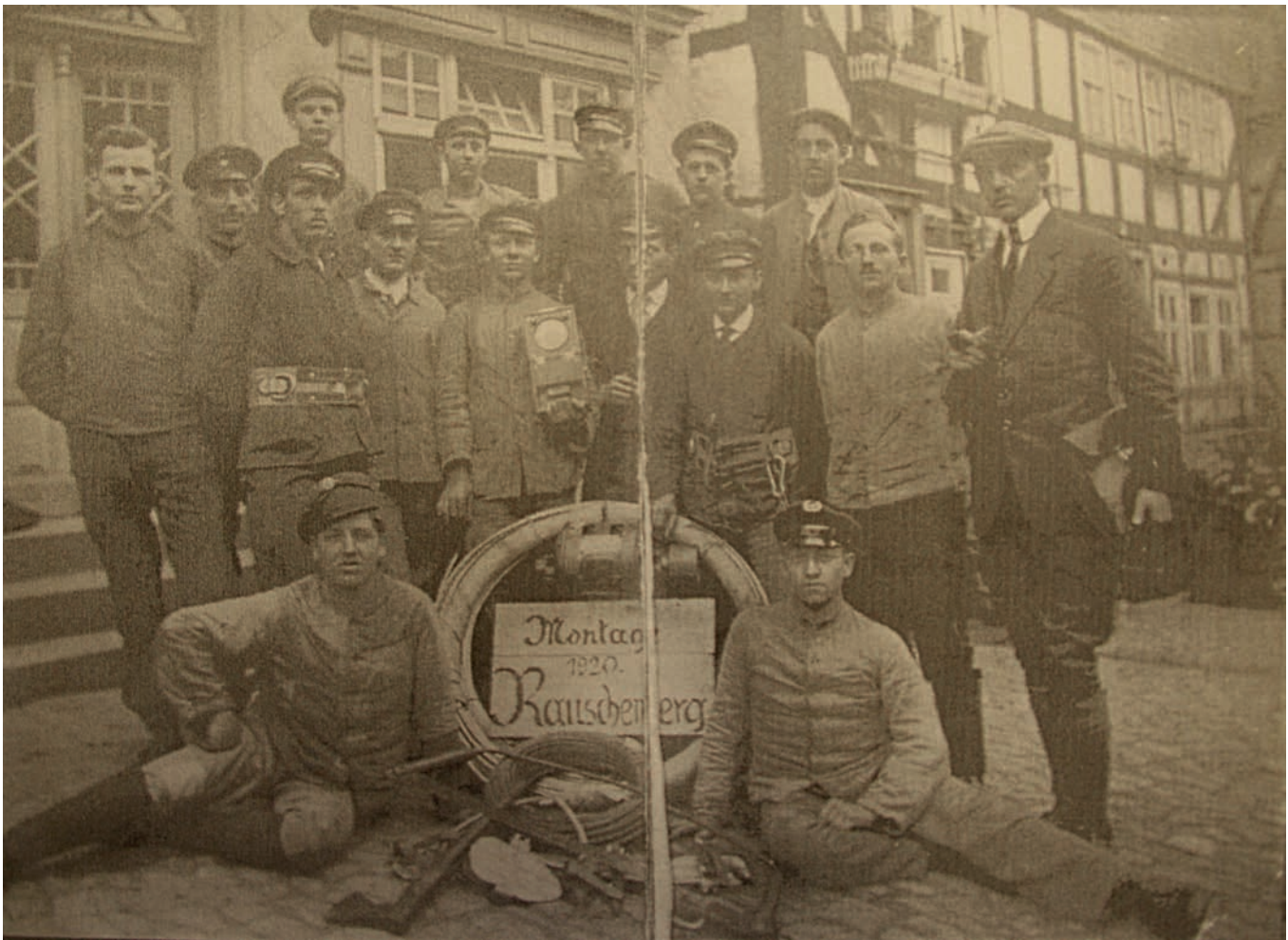
Montagetrupp zur Errichtung des Ortsstromnetzes Rauschenberg, 1920
