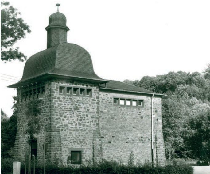
Transformatorhaus, Lahn-Dill-Kreis Fotosammlung E. Schneider, Landkreis Marburg-Biedenkopf
