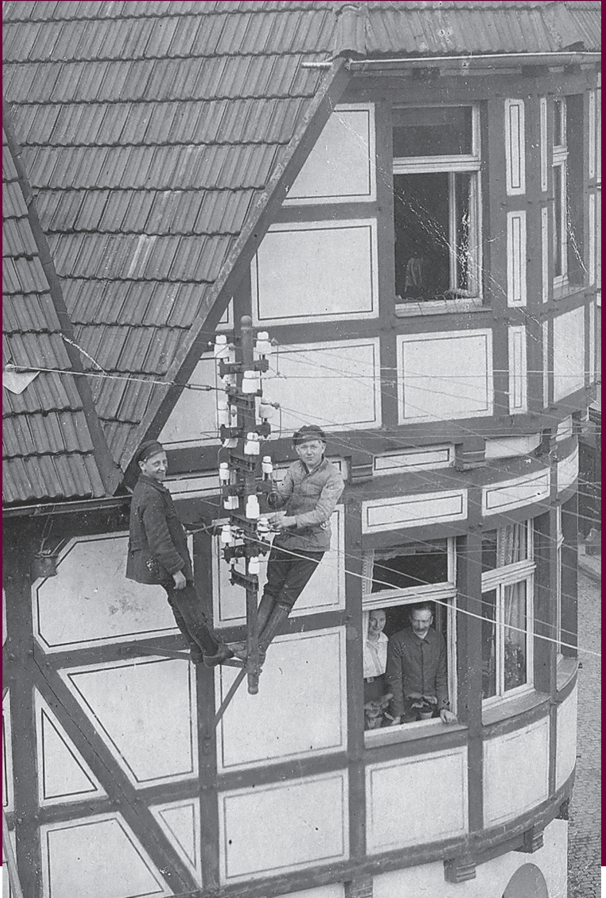
Die Stromleitungen liefen über Masten mit Isolatoren aus Porzellan und wurden über Dachständer in die Haushalte geführt. Monteure arbeiten an einer Stromleitung in Frankenberg, Landkreis Waldeck-Frankenberg, um 1925
