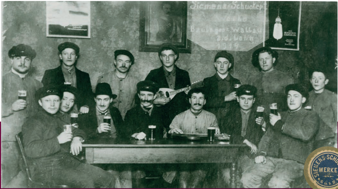
Baukolonne der Siemens-Schuckert-Werke GmbH nach Feierabend in Wallau, 1914
