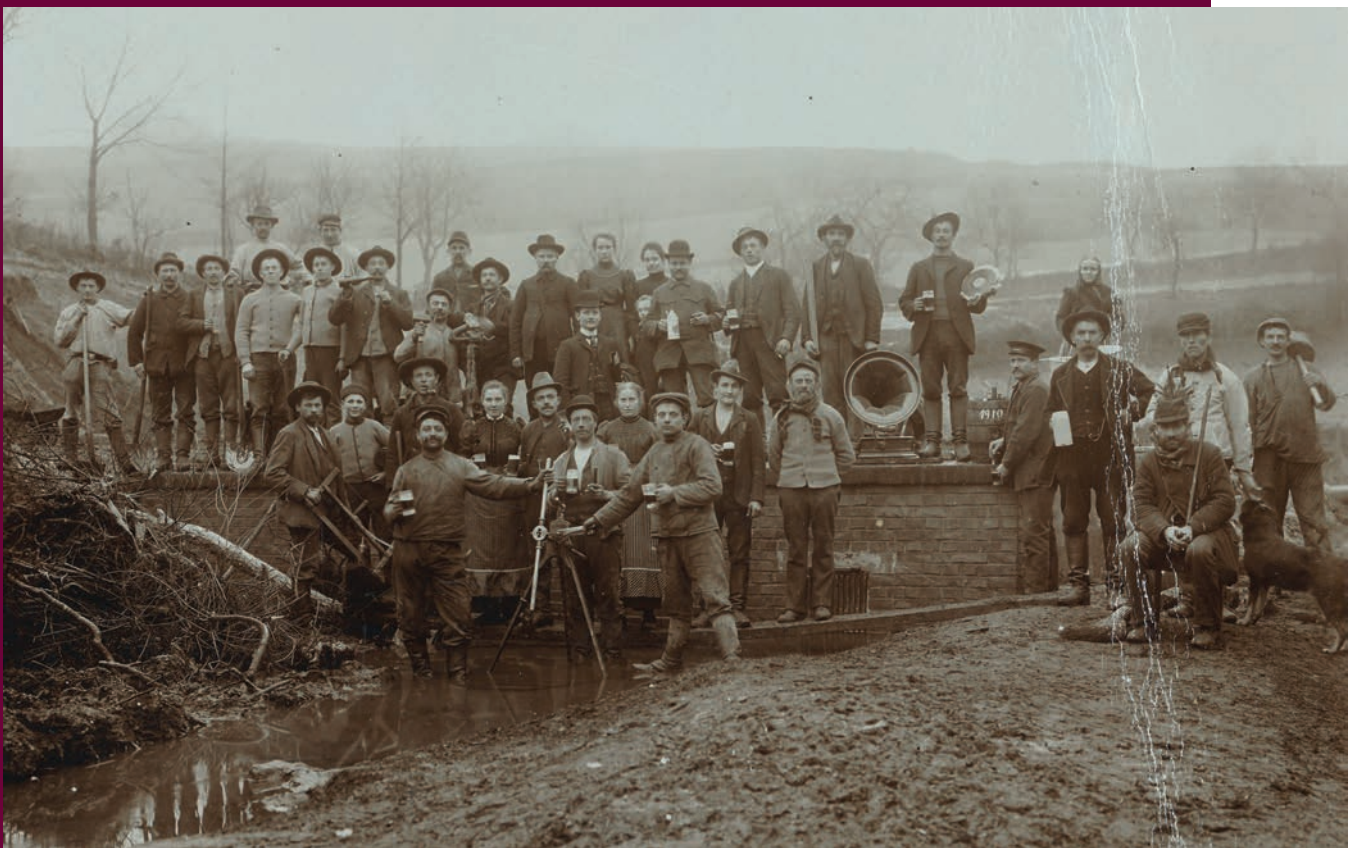
Bau des Gruppenwasserwerks Gemünden-Bunstruth, Landkreis Waldeck-Frankenberg, 1910
