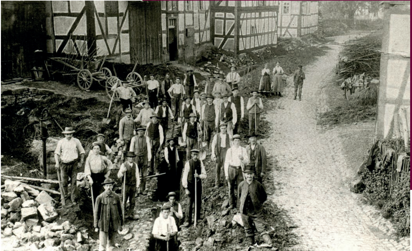
Bau der Wasserleitung in Bottendorf, Landkreis Waldeck-Frankenberg, 1910
