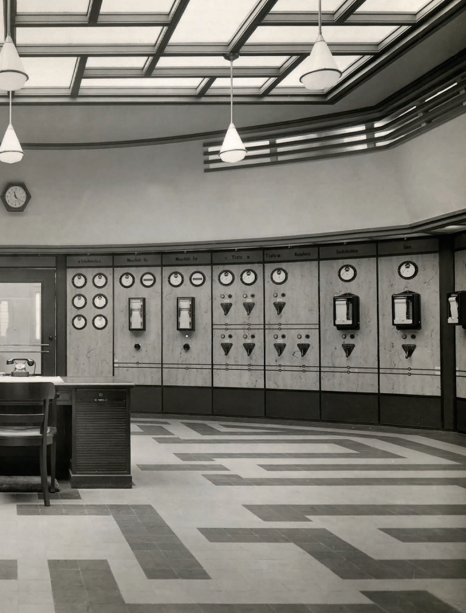
Die Schaltwarte der Hessen-Nassauischen Überlandzentrale Oberscheld, Lahn-Dill-Kreis, 1928 Zur Verfügung gestellt von Manfred Ritter, Wetter
