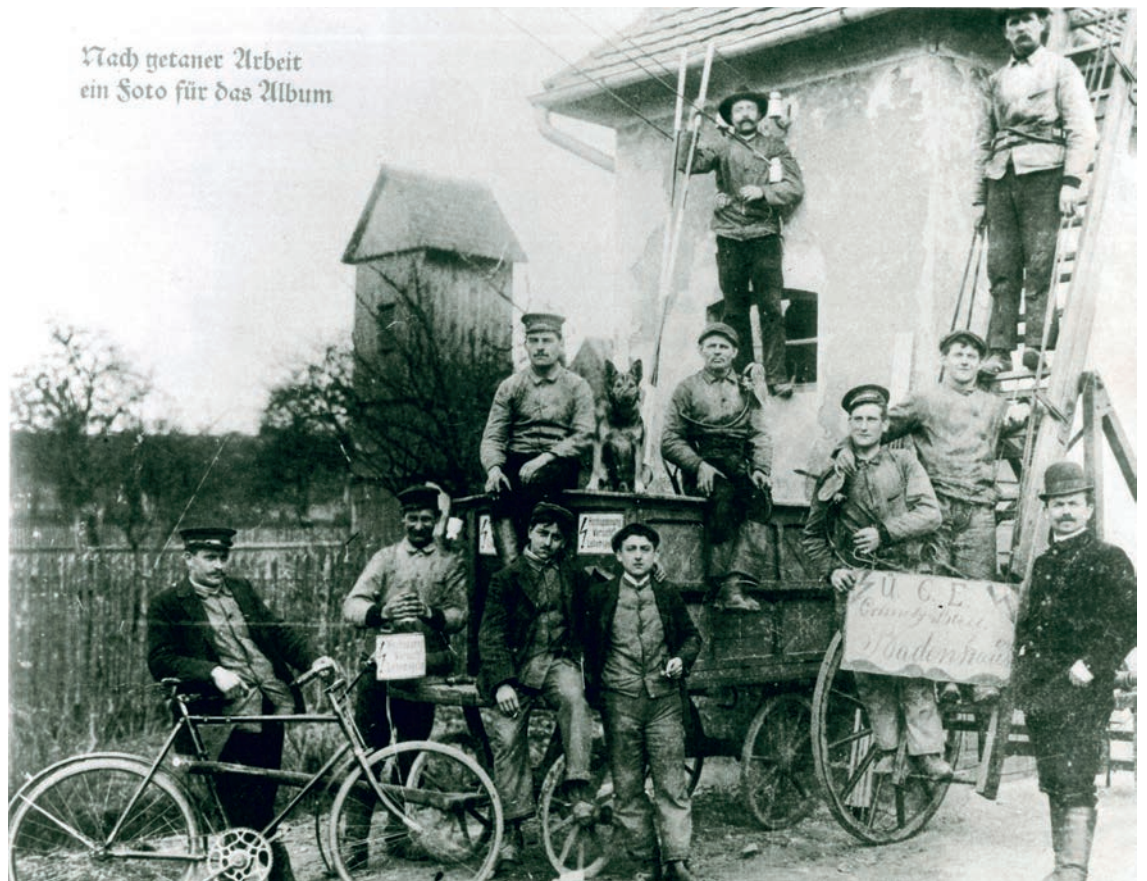
Bau eines Ortsstromnetzes, Landkreis Waldeck-Frankenberg, um 1920
