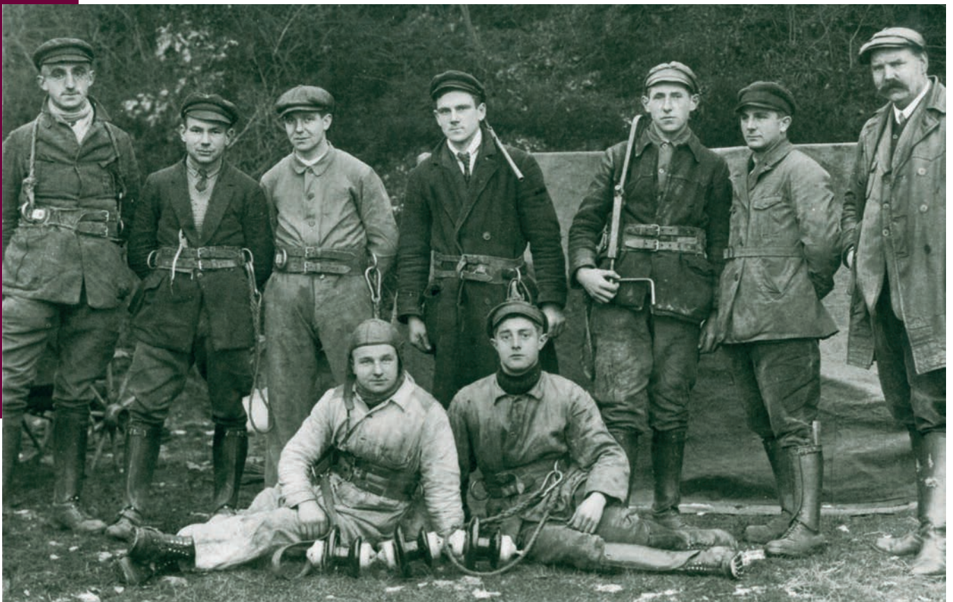
Bau eines Ortsstromnetzes, Landkreis Waldeck-Frankenberg, um 1921
