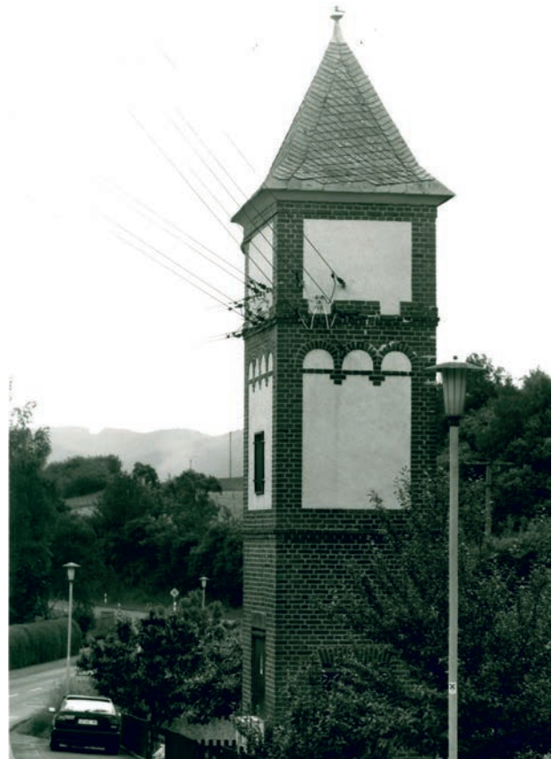
Transformatorhaus in Kleingladenbach, Landkreis Marburg-Biedenkopf Fotosammlung E. Schneider, Landkreis Marburg-Biedenkopf
