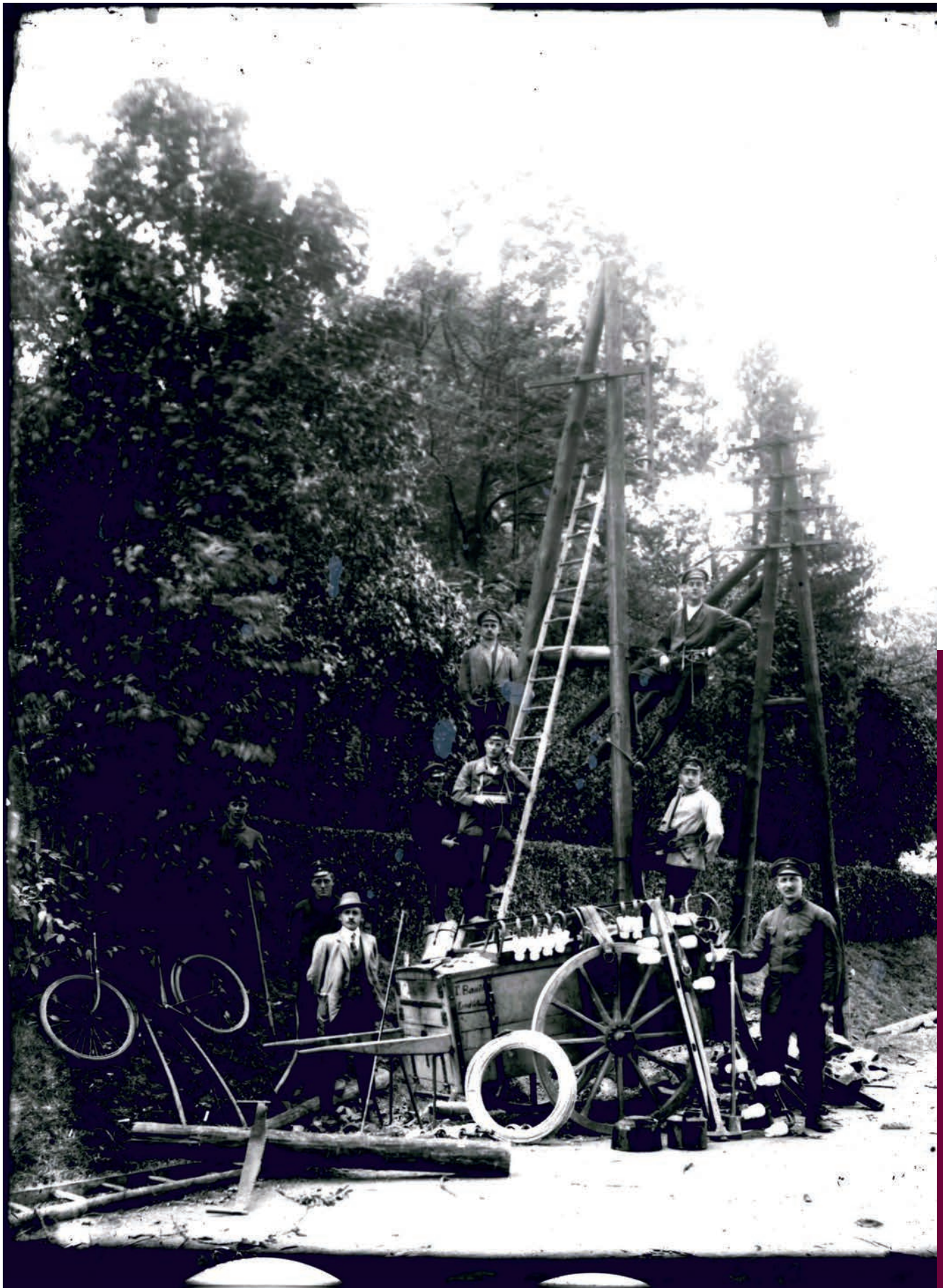
Bautrup installiert die Strom- und Fernmeldeleitungen in Biedenkopf, Landkreis Marburg-Biedenkopf, 1901-1904
